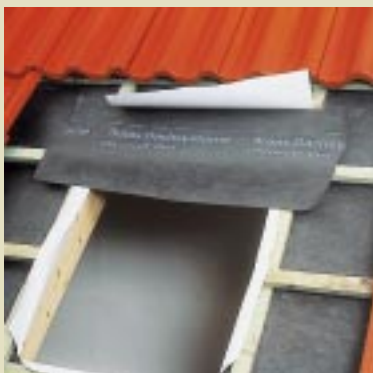
↑ Zum Einbau der wasserabweisenden Rinne werden Konterlattenstücke entfernt und die Bahn an dieser Stelle eingeschnitten. Nun kann ein zusätzlicher Bahnenstreifen eingeschoben werden.
