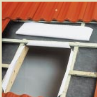
↑ Der Streifen wird nach oben umgeschlagen und befestigt. Die Rinne muss schräg verlaufen, damit sich kein Wassersack bildet und das Wasser in ein benachbartes Sparrenfeld abgeleitet wird.
