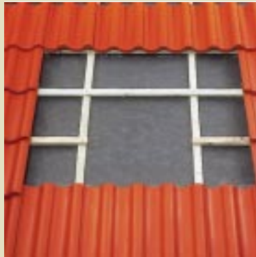
↑ ... werden die Traglatten an der späteren Fensterposition ausgeschnitten.
