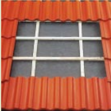
↑ Nach dem Entfernen der Dachsteine im Arbeitsbereich ...
